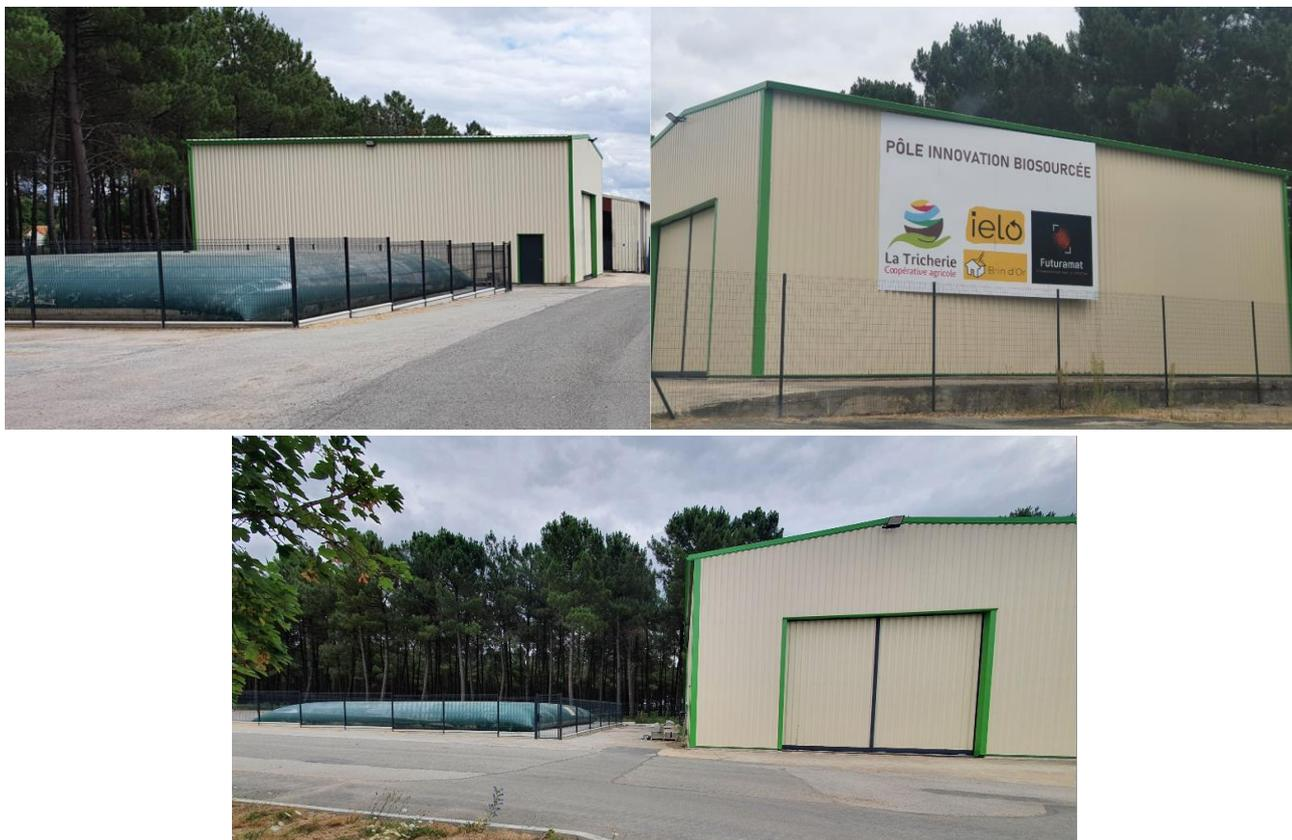
**PHOTO 16 : BATIMENT 4 - LOCAL TECHNIQUE D'ALIMENTATION EN EAU EN CAS D'INCENDIE ET RESERVE D'EAU DE 240 m<sup>3</sup> ALIMENTANT LE POTEAU INCENDIE DU SITE, LES RIA ET LES RIDEAUX D'EAU**
