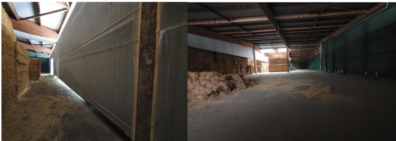
**PHOTO 6 : FILETS ANTIPOUSSIERES SUR TOUTES LES FACADES INTERIEURES + TRAVEE DU COTE DE LA LIMITE DE PROPRIETE VIDE DE TOUT STOCKAGE.**
