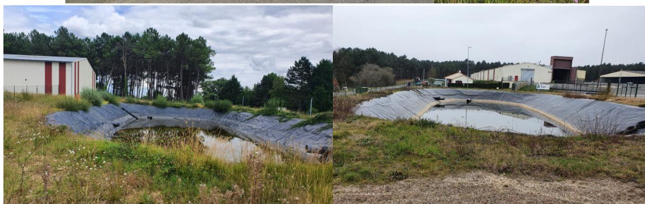
**PHOTO 19 : BASSIN DE CONFINEMENT DES EAUX D'INCENDIE COMMUN DU SITE, ACCES ET VANNE D'OBTURATION DU BASSIN EN CAS D'INCENDIE**
